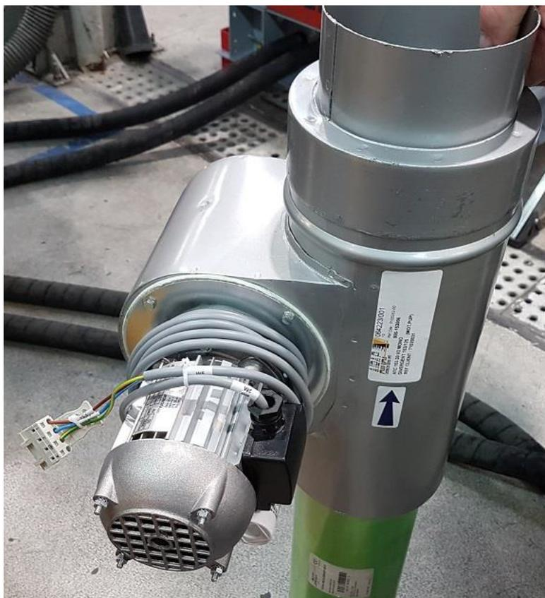
ケーブルをほどき、下の写真のようにパイプ（ボイラーの通気管）に固定します。
