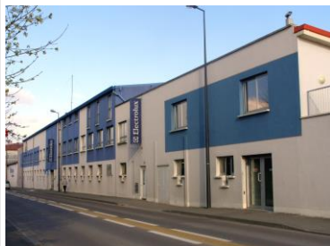
Usine Electrolux Professional à Rosières près de Troyes
